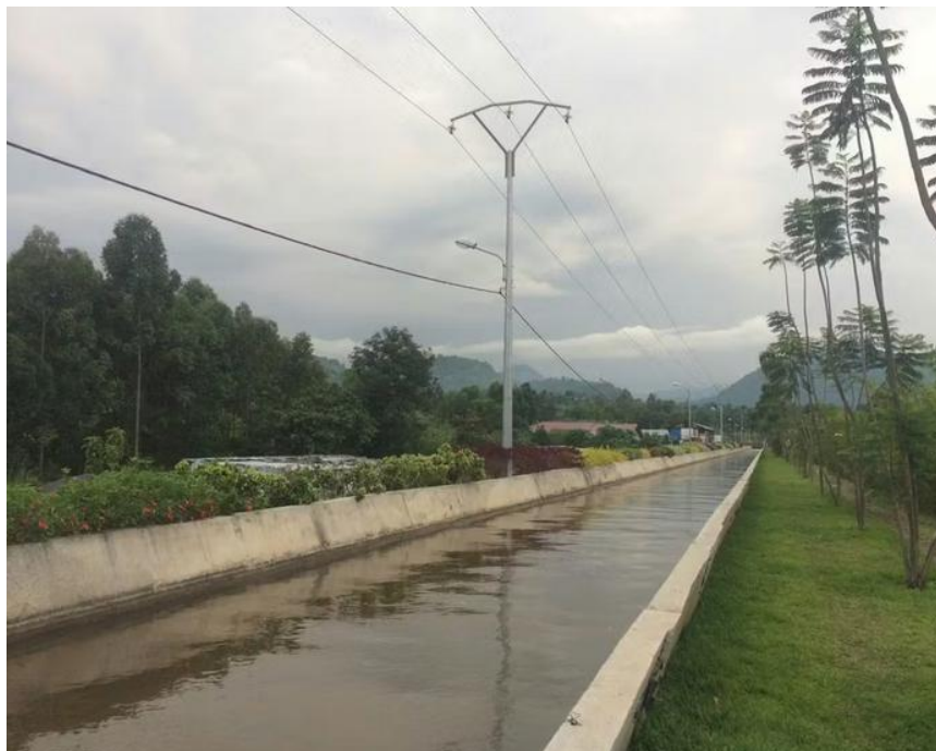
Das Wasserkraft-Inselnetzwerk, das Goma mit Strom versorgt. Foto Nik Stoop
