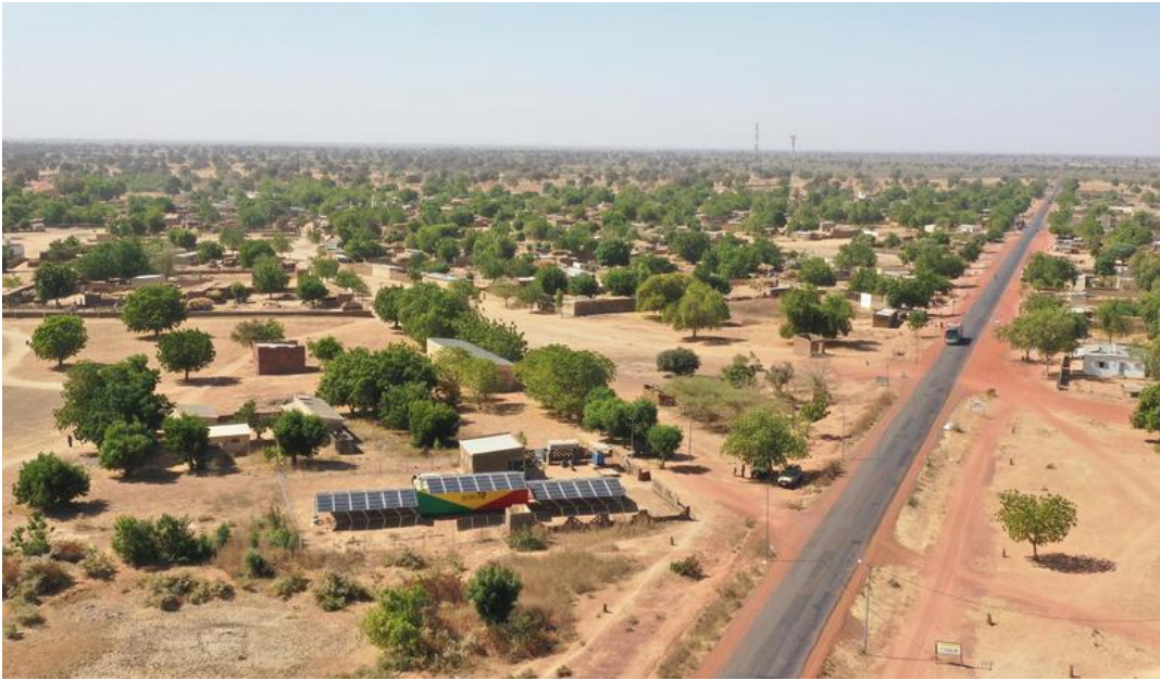
ein auf Solarstrom basierendes Inselnetzwerk in Cinzana Gare, Ségou-Region, Mali 1
