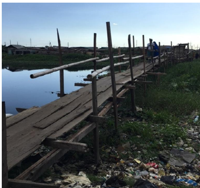
Brücke durch ein Sumpfgebiet in Ijora 14
